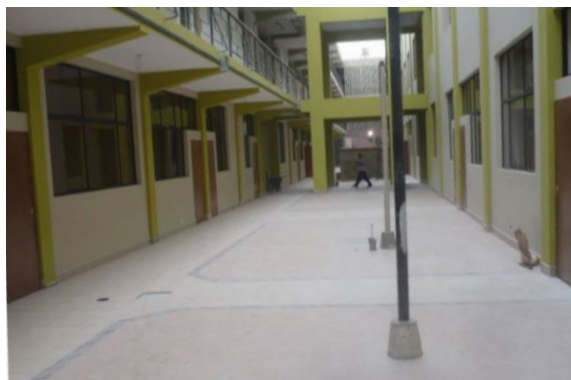
Elaboración del Expediente Técnico y la Ejecución de la Obra Reconstrucción y Reequipamiento de las Aulas del Local Central de la Universidad San Luis Gonzaga de Ica
